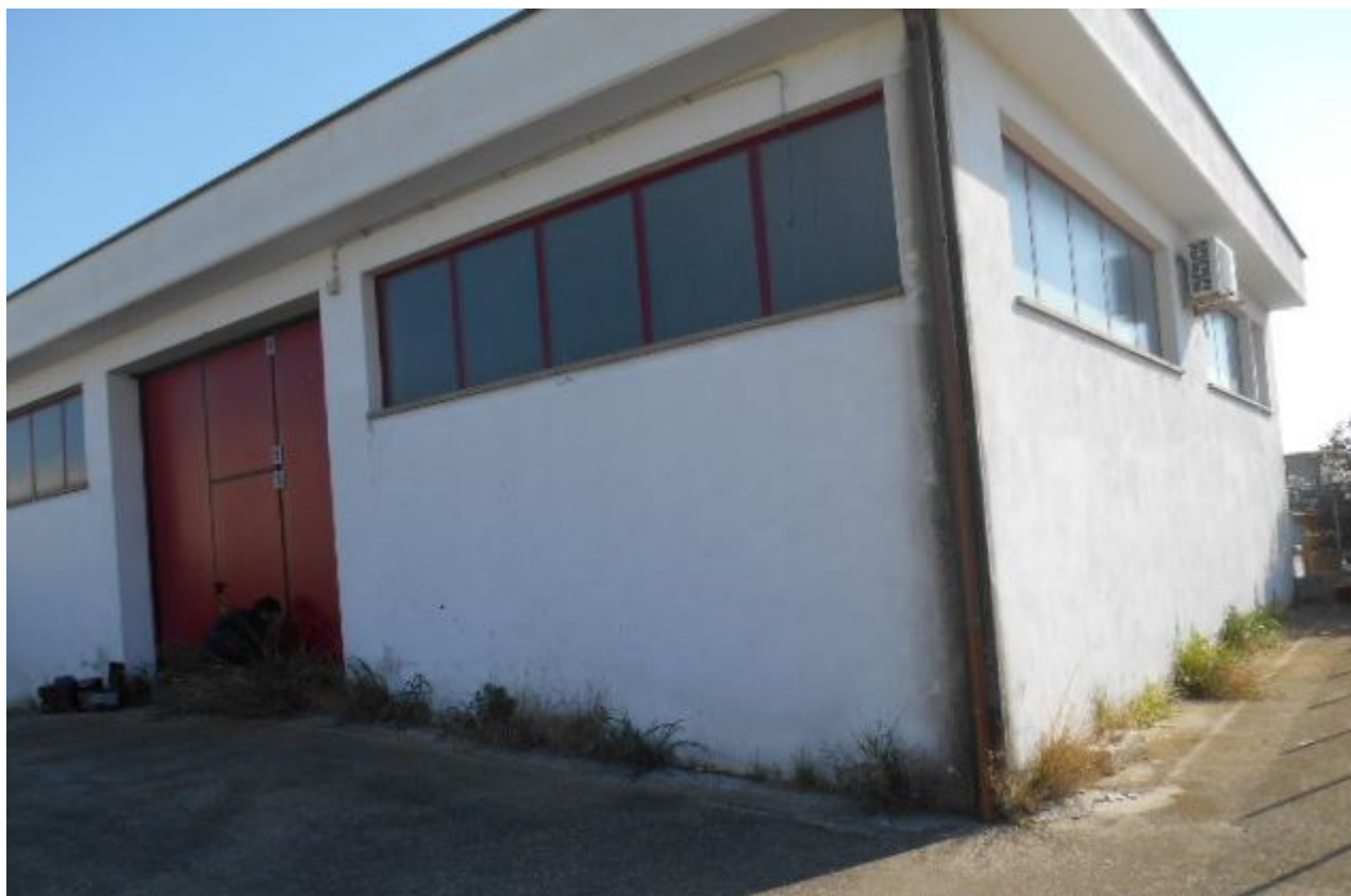
FOTO 14 Vista del Magazzino dalla corte esterna di proprietà
