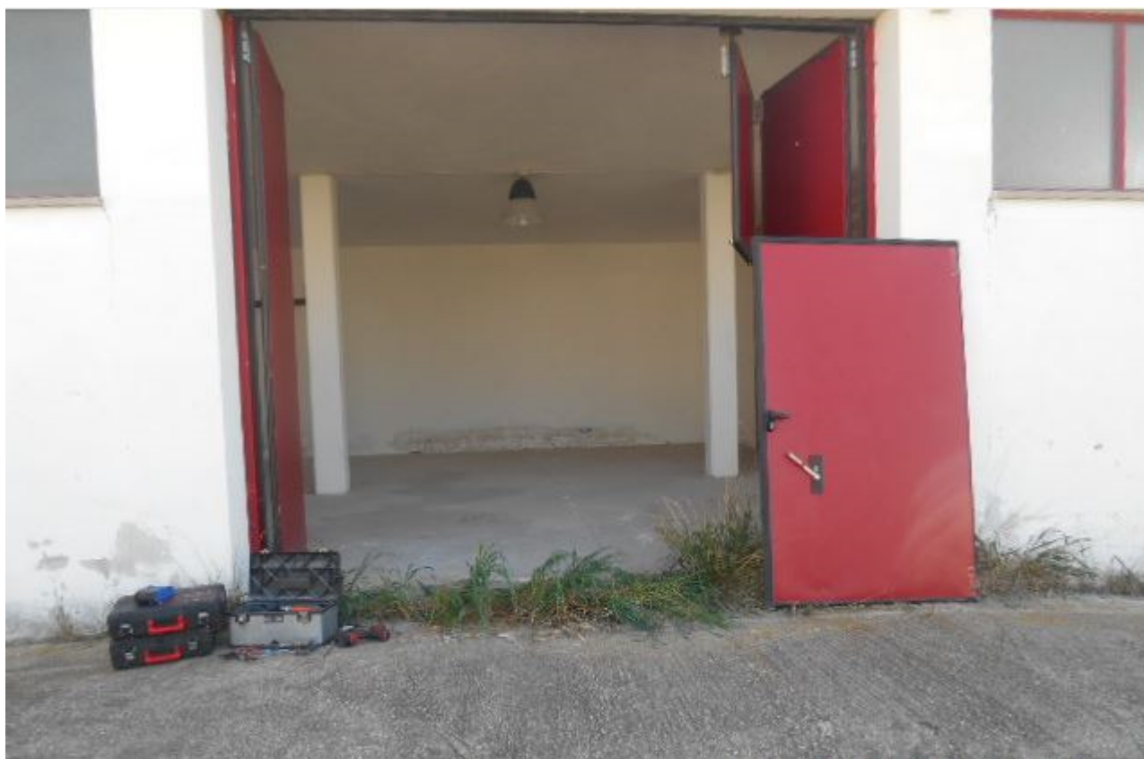
FOTO 6 Vista dell'accesso al Magazzino con porta aperta
