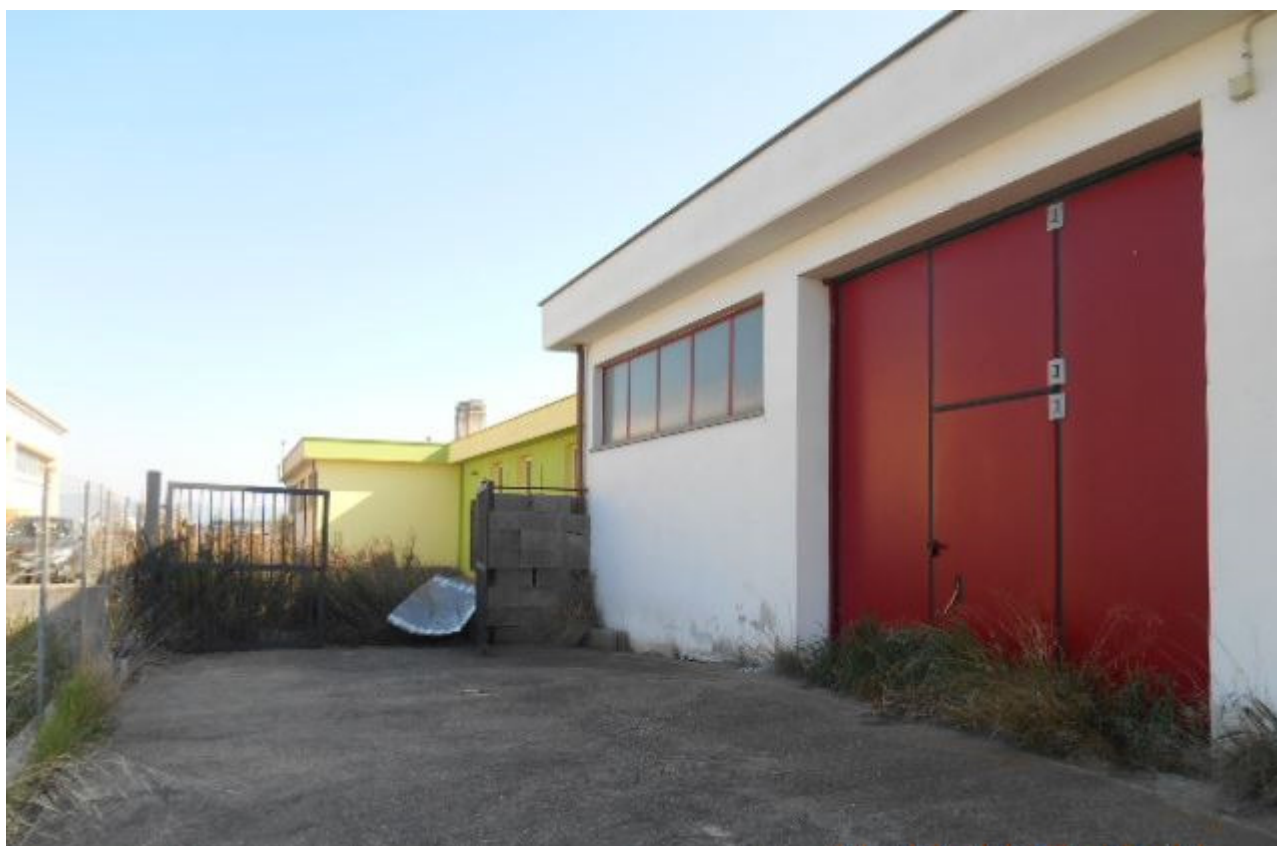
FOTO 5 Vista dell'accesso al Magazzino
