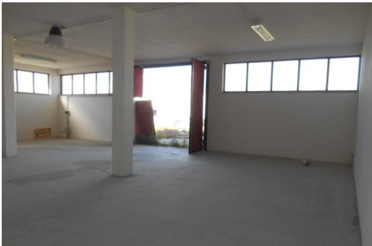
FOTO 7 Vista del Magazzino dal suo interno
