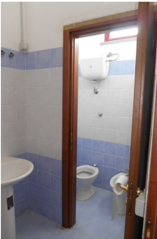
FOTO 11 Vista del Magazzino dal suo interno – locale sanitario
