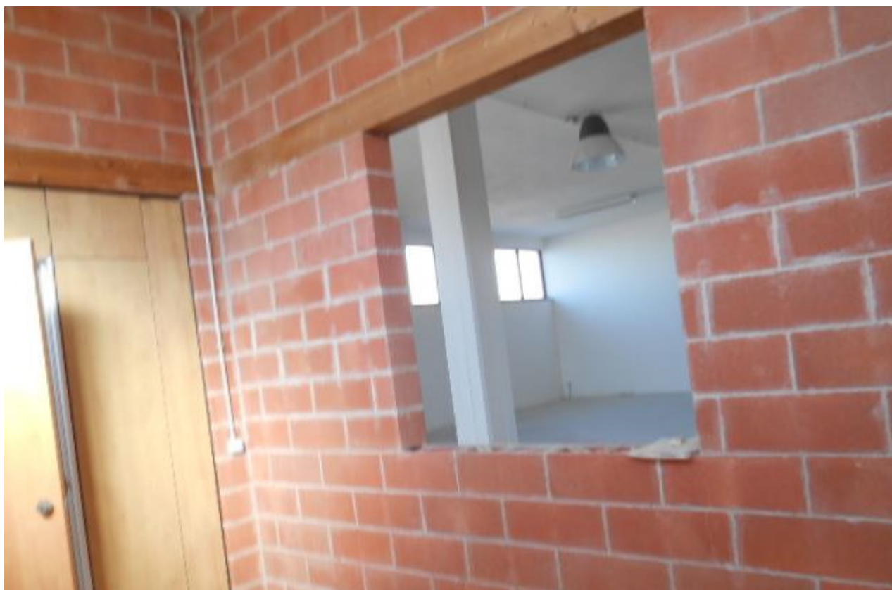
FOTO 9 Vista del Magazzino dal suo interno
