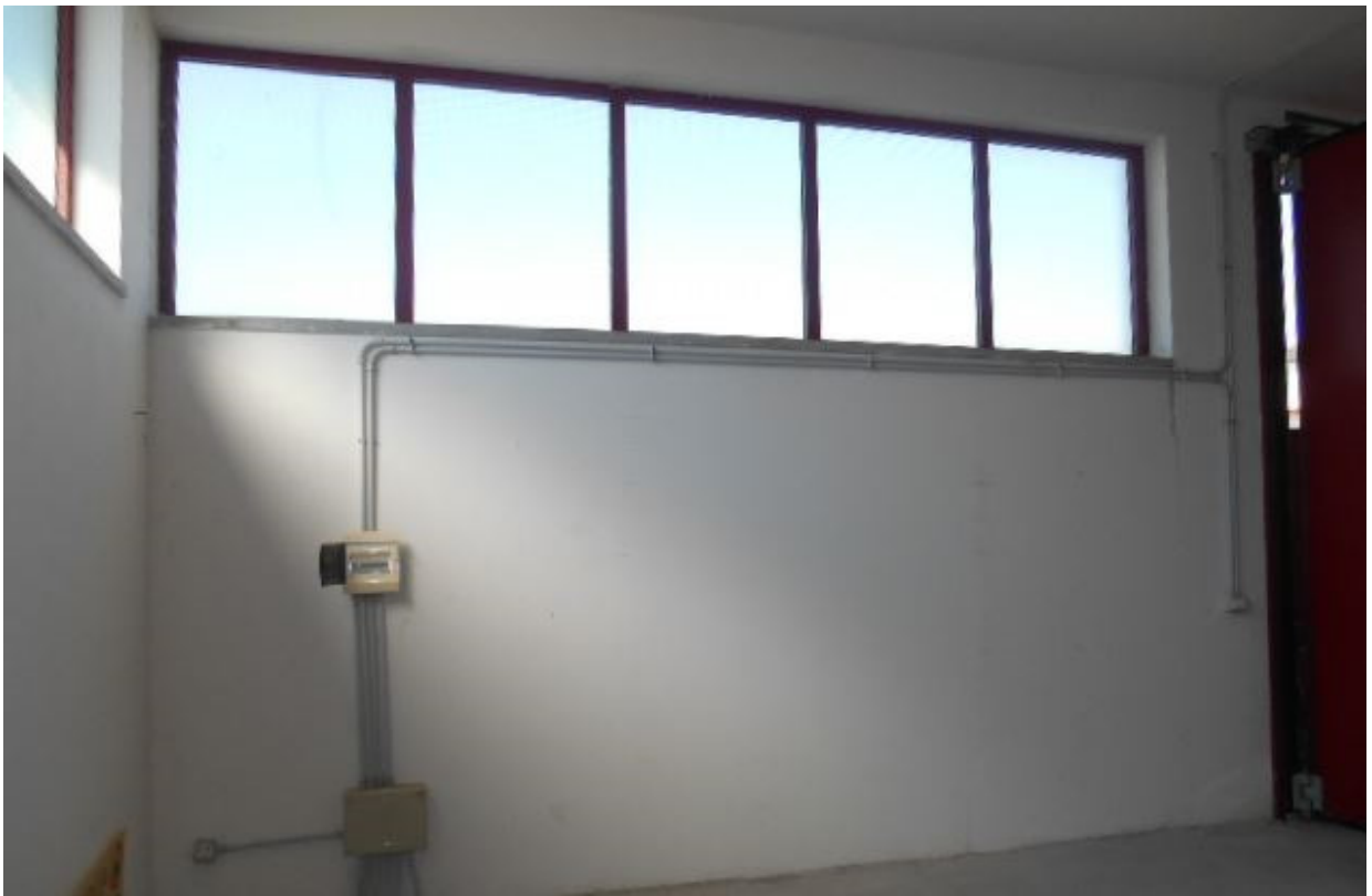
FOTO 10 Vista del Magazzino dal suo interno
